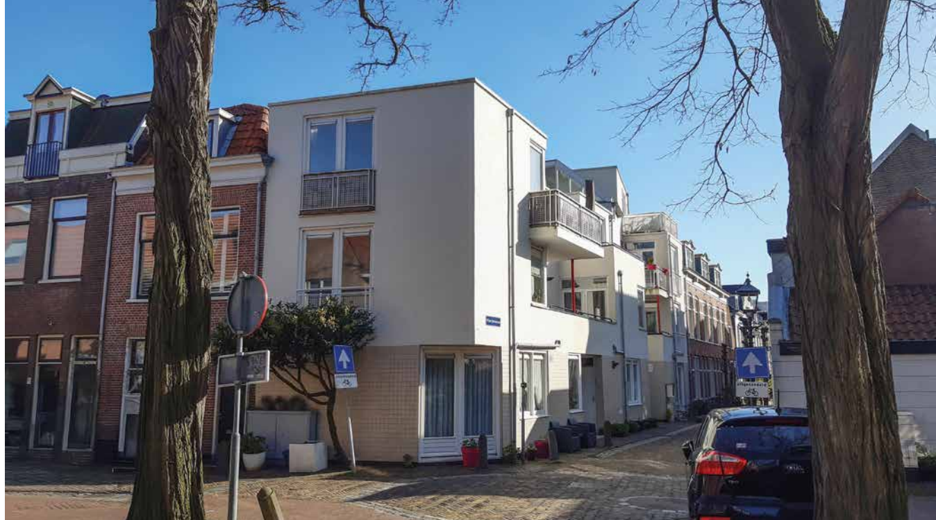
Woningbouw Witte Herenstraat, architect Wiek Röling, 1986-1987
